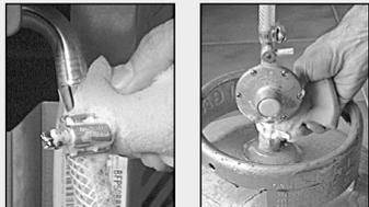
5. Após a instalação, abra o registro de gás e utilizando uma esponja com água e sabão, verifique se há vazamento em todas as conexões, incluindo toda a extensão da mangueira. Se houver formação de bolhas na conexão, refaça-a. Se houver bolhas em qualquer região da mangueira, efetue a substituição da mesma.
