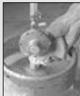
5. Após a instalação, abra o registro de gás e utilizando uma esponja com água e sabão, verifique se há vazamento em todas as conexões, incluindo toda a extensão da mangueira. Se houver formação de bolhas na conexão, refaça-a. Se houver bolhas em qualquer região da mangueira, efetue a substituição da mesma.
