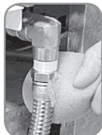
1. Rosqueie a mangueira metálica no registro de gás da parede com o auxílio de duas chaves de boca. O ponto de abastecimento de gás tem que permitir a instalação da mangueira flexível metálica de maneira que ela fique paralela a parede evitando-se assim um estrangulamento.
